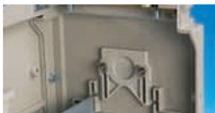
Detail vnitřní konstrukce
